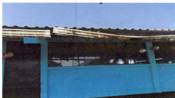
Foto 4: Sustrucción de canales de pvc
