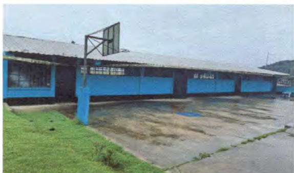
Foto 9: Sustitución de ventanas
