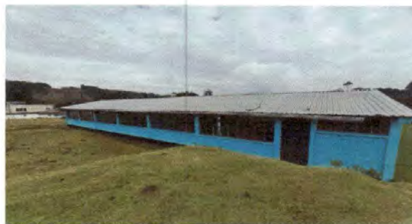
Foto 10: Sustitución de ventanas
