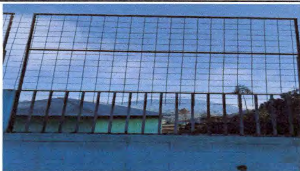
Foto 5: Mantenimiento de barandas de metal
