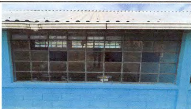
Foto 3: Sustrucción de ventanas
